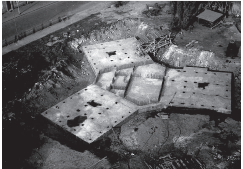
ABB. 22 Fundamentplatte mit Anschluss für den Gleitkern für ein Y-Haus in Dessau (1969)
